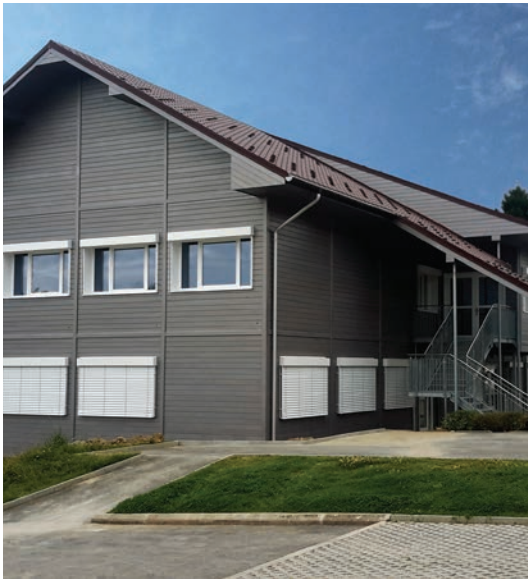
Froidville - Rez-de-chaussée: UAPE de 66 places, cuisine agencées, sanitaires, WC handicapés, chauffage à distance, vestiaires et bureaux administratifs. Premier étage: École avec 3 salles de classes, vestiaires, sanitaires et local conciergerie et UAPE
